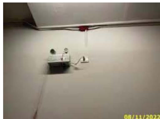
ระบบไฟส่องสว่างฉุกเฉิน
