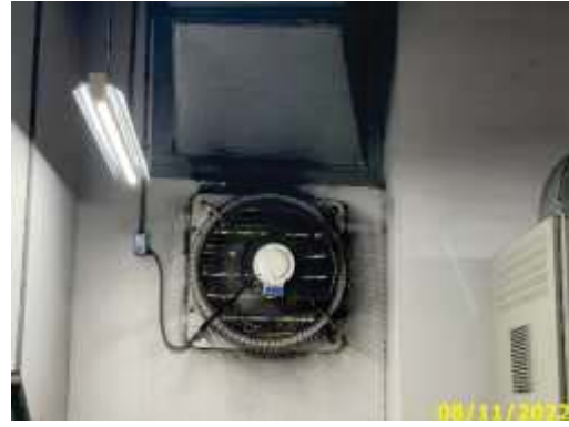
ระบายอากาศโดยใช้พัดลมระบายอากาศ
