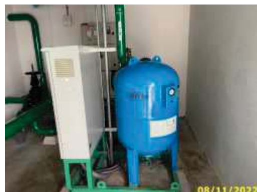
Booster Pump ชั้นดาดฟ้า
